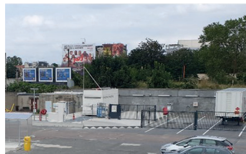
Station de distribution en hydrogène
