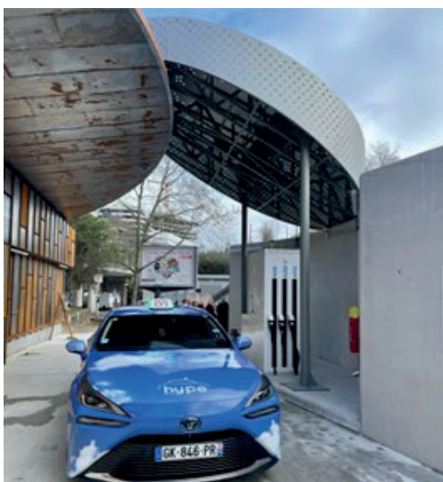
Zone de distribution avec dispenser
