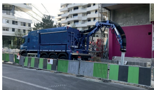
Utilisation d'une aspiratrice / excavatrice
