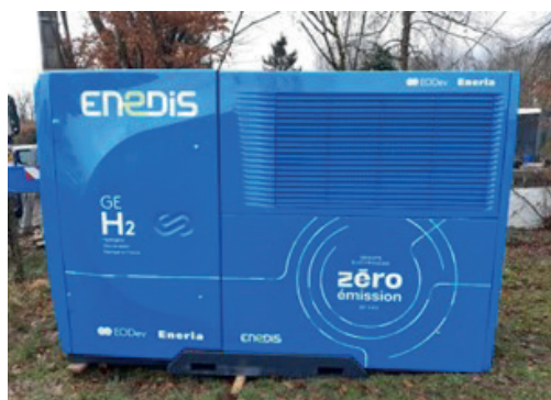
Groupe électrogène à hydrogène
