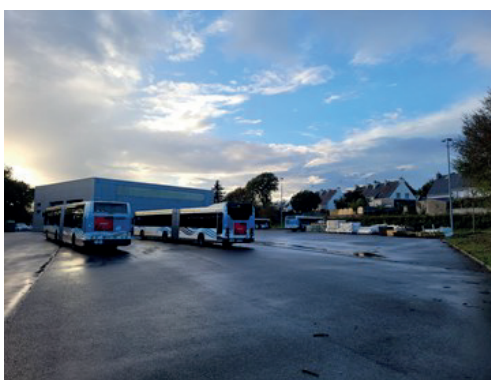
Vue du dépôt avant travaux
